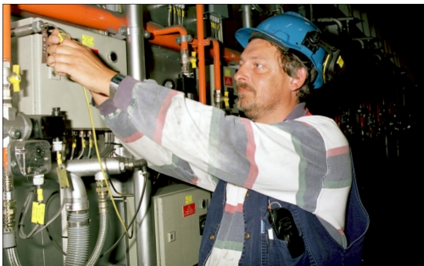
- Vi testar alla temperaturgivare två gånger om året och kasseras givare som ligger utanför toleranserna för processen, berättar Jan-Olle Granelli.
